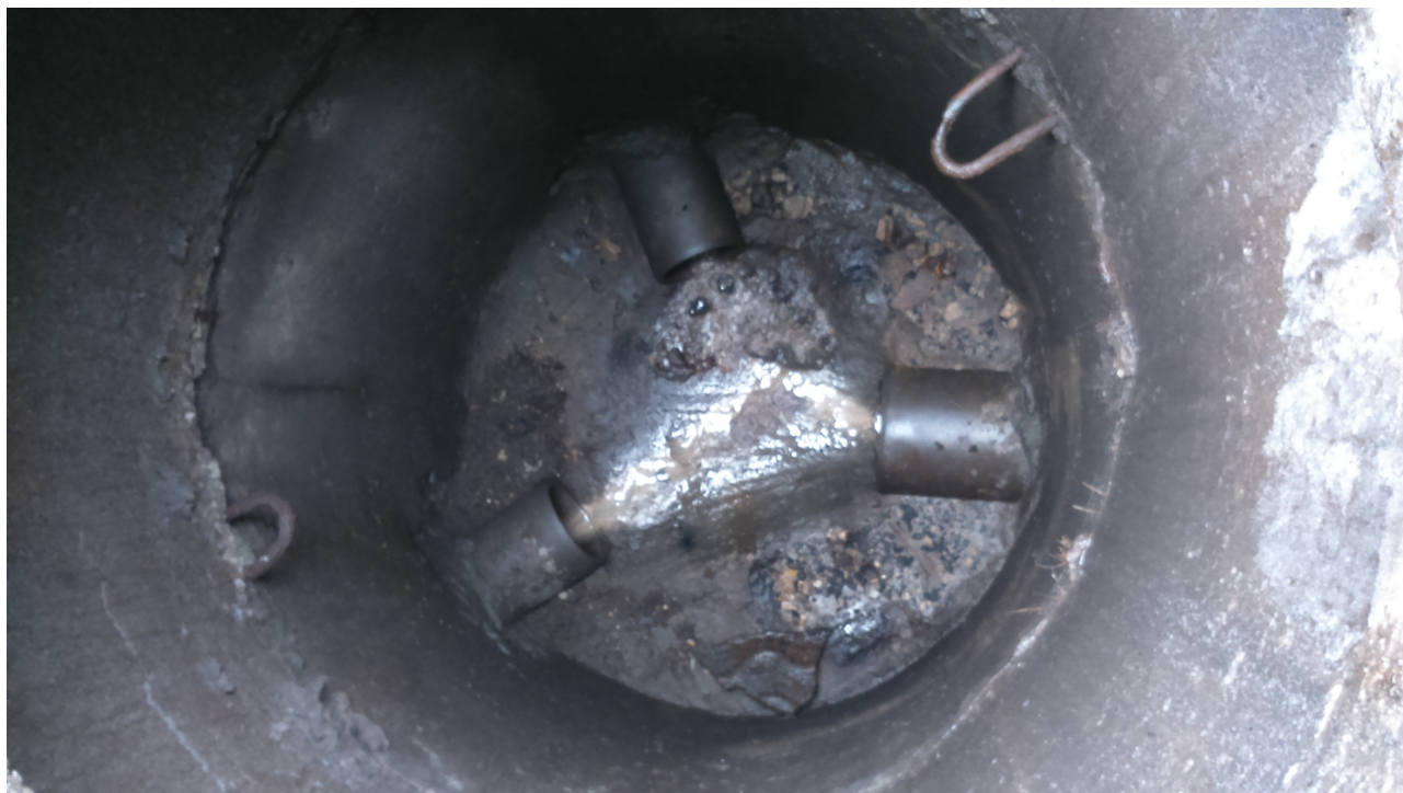
Foto 1 Kanalisatsioonikaev K-2 sisevaade
